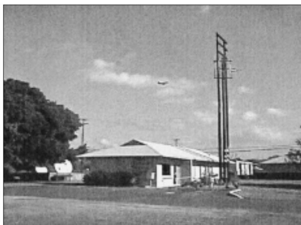
Антенны геостационарного спутника (слева, частично закрыты деревьями) и радиоантенны ОВЧ (справа над вышкой) являются частью многих линий коммуникаций Тихоокеанского центра предупреждения о цунами.
