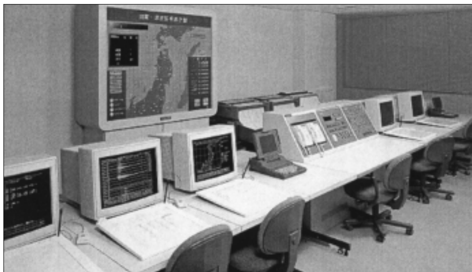
Пульт управления одного из шести центров предупреждения о цунами в Японии. С помощью автоматизированной Системы наблюдения за землетрясениями и цунами осуществляется постоянный мониторинг сейсмических сигналов, регистрируются землетрясения и обрабатываются соответствующие данные.
