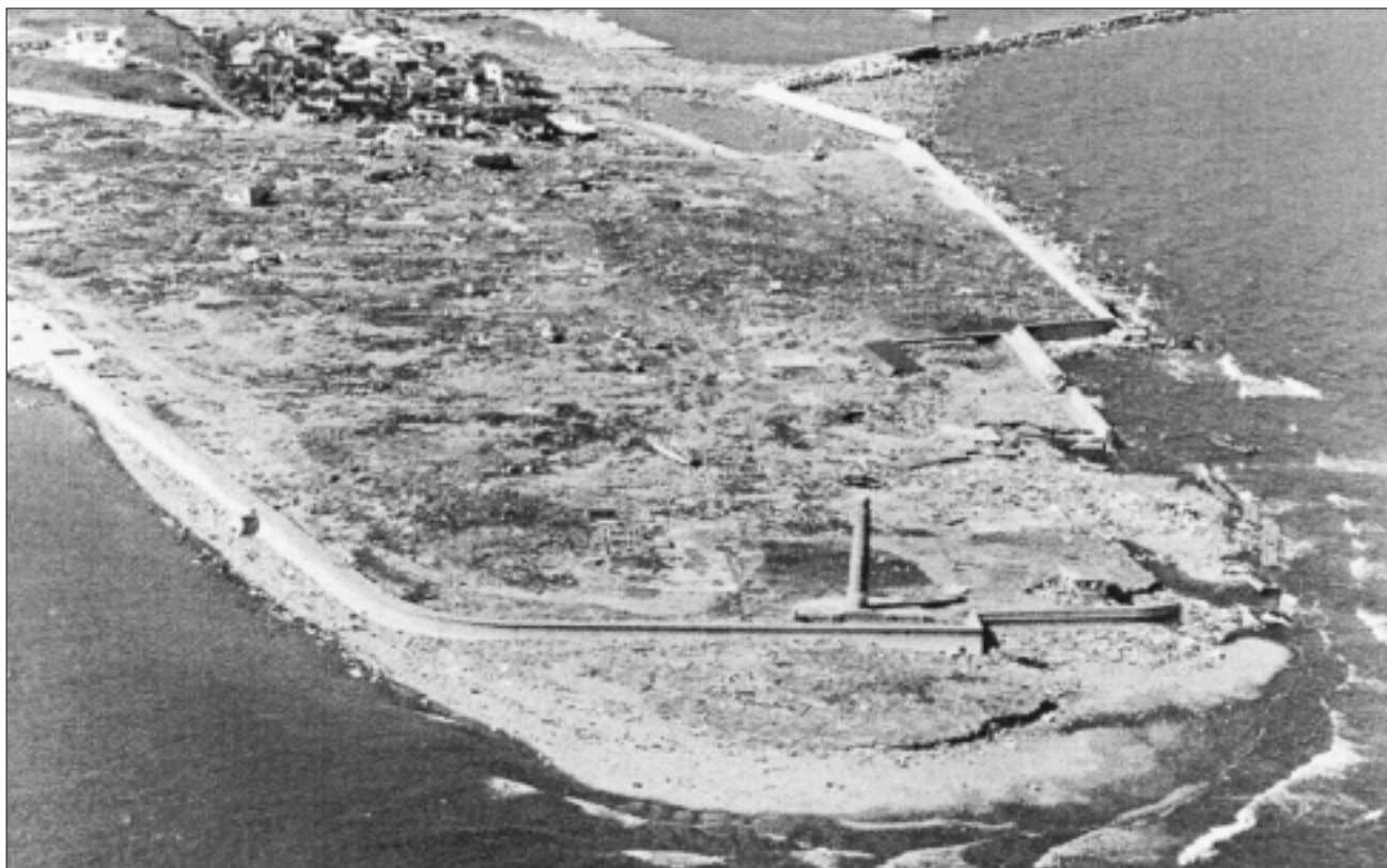
Массовые разрушения в городе Аонае на острове Окусири, Япония, вызванные региональным цунами 12 июля 1993 г.
