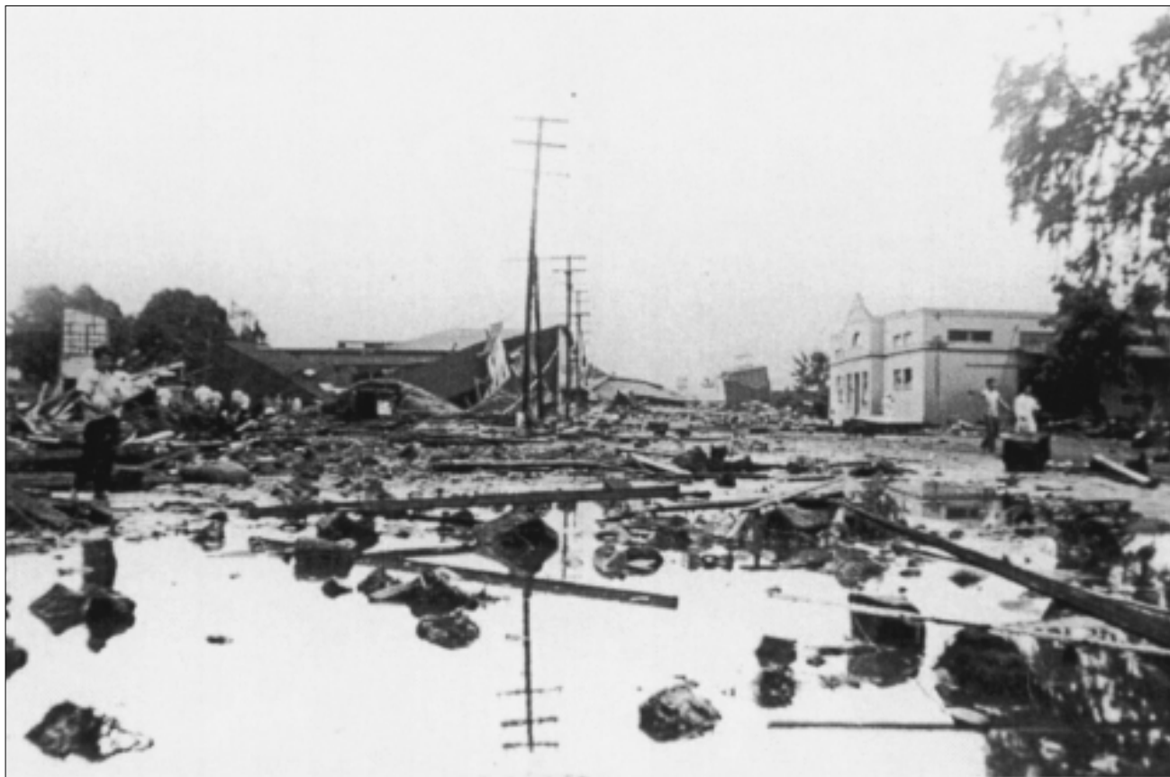
Береговая линия в Хило (Гавайские острова): разрушения, нанесенные распространяющимся по всему Тихому океану цунами, возникшим у побережья острова Унимак (Аляска, США) 1 апреля 1946 г.
